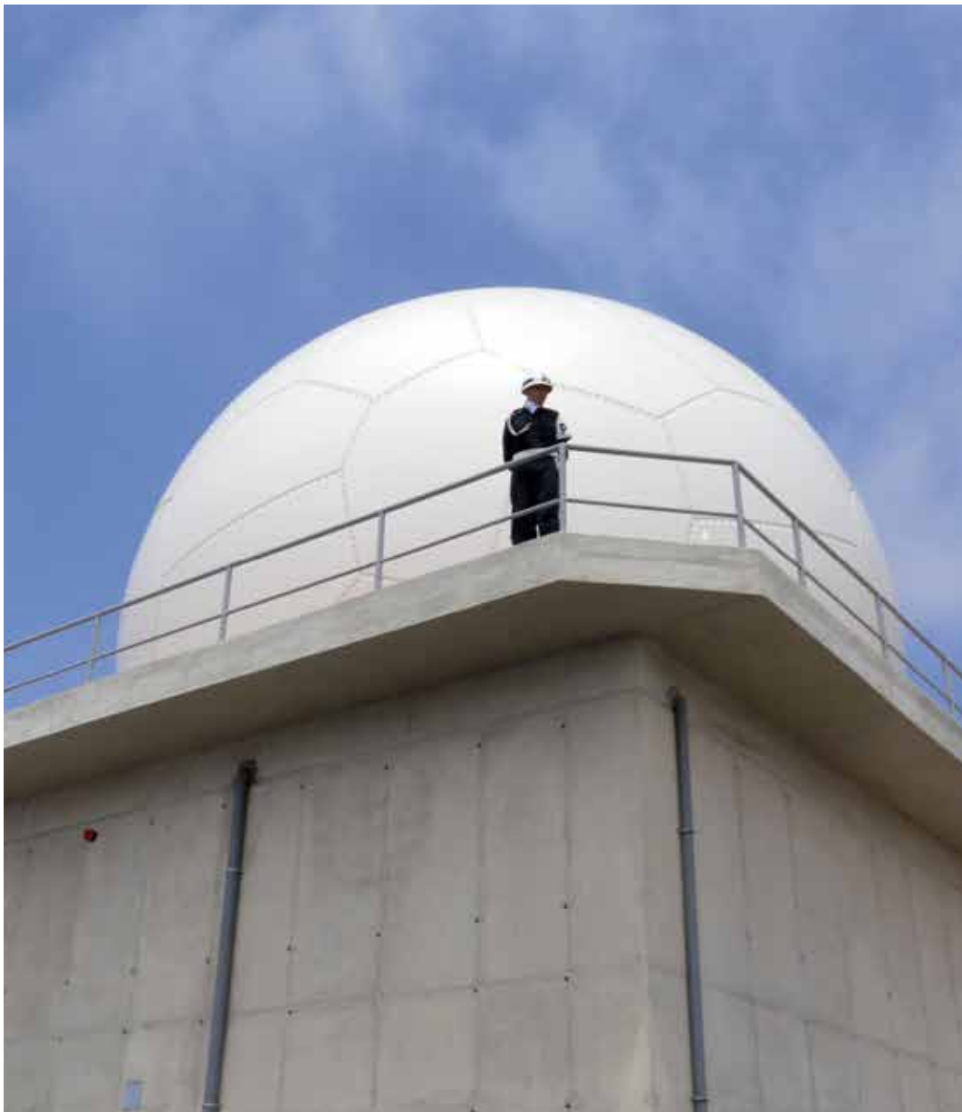
PROTECCIÓN. Domo de seguridad que resguarda la antena receptora.
